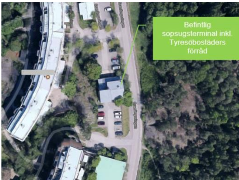
Figur 2. Befintlig anläggning i Granängsringen
