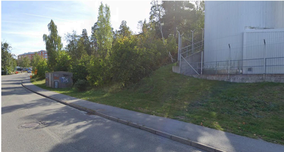
Figur 2: Foto över föreslagen placering av ny och befintlig nätstation.
