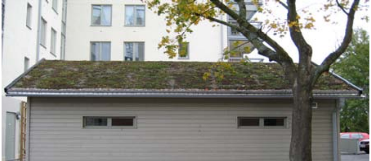
Sedumtak, en metod för lokalt omhändertagande av dagvatten
